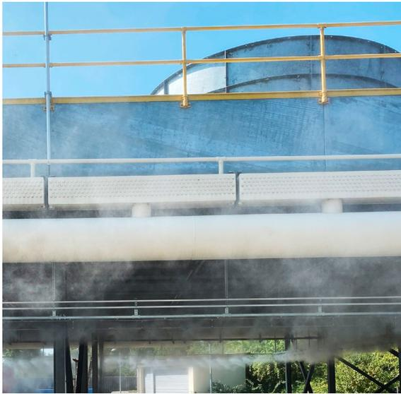
▲ Abb. 1: Vernebelungssystem unter dem Luftkühlerfeld im Betrieb
